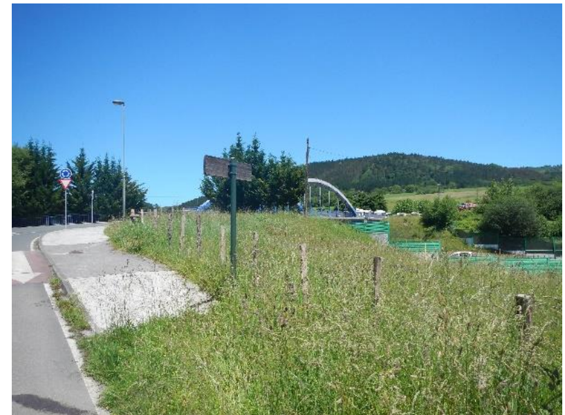
Zona de instalaciones y accesos junto al P.I 0+800.
